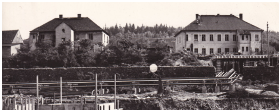
Stará pošta, na pravé straně Hospodářství, v popředí zeď bývalého parku u Bílého domu. Foceno od řeky, červen 1965. Zdroj: archiv Dalibora Koláře
